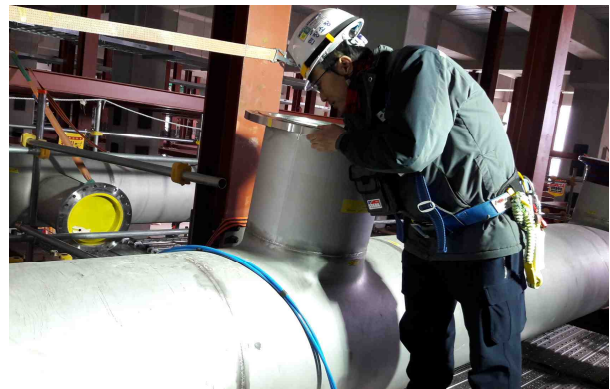
배관 및 저장탱크 등의 내부 용접 작업장소
